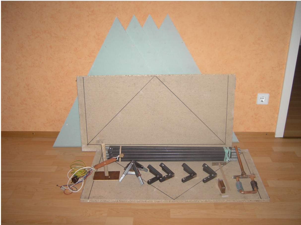
Abbildung 13 Einzelteile zerlegt. Hinten stehen die Gipskartonplatten
